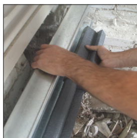
Aanbrengen thermostrip
