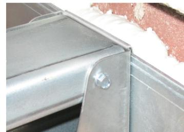
**POUTRE DANS UN ÉTRIER À CROCHET**
