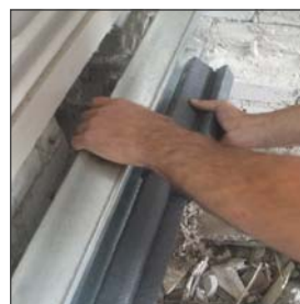
Application bande thermique
