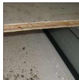
Panneaux en bois avec poutres en acier Combifor
