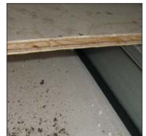
Holzplatten mit Combifor Stahlträger
