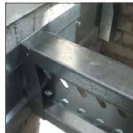
Profilträger mit Hakenbügelprofil
