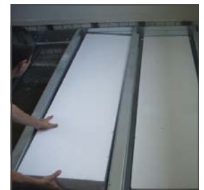
Anbringen von Isolationsplatten
