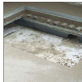
Schwalbenschwanzplatte mit Estrich
