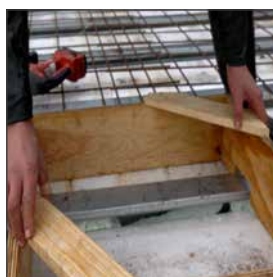
Bekisting en wapening plaatsen
